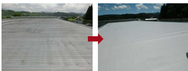
屋上の防水遮熱塗料塗布による省エネ (宮崎富士通コンポーネント鉄肥工場)
